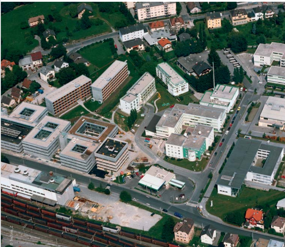
Das Techno_Z in Salzburg-Itzling im Jahr 1998, kurz vor Fertigstellung des Bauteils 10
